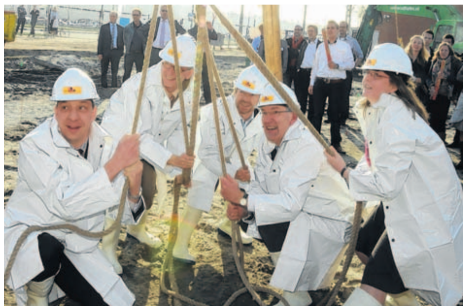
Met vereende krachten wordt de feestelijk gekleurde rood-wit-blauwe heipaal in de grond geslagen, waarna de bouwplaats werd overspoeld met confettiregen. FOTO: MARIANKA PETERS
